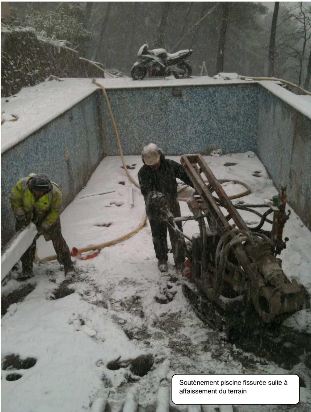
Soutènement piscine fissurée suite à affaissement du terrain
